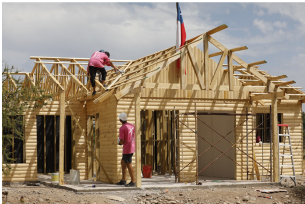
Construcción de casa por voluntarios de Viviendas UC. ©Archivo Pastoral UC
